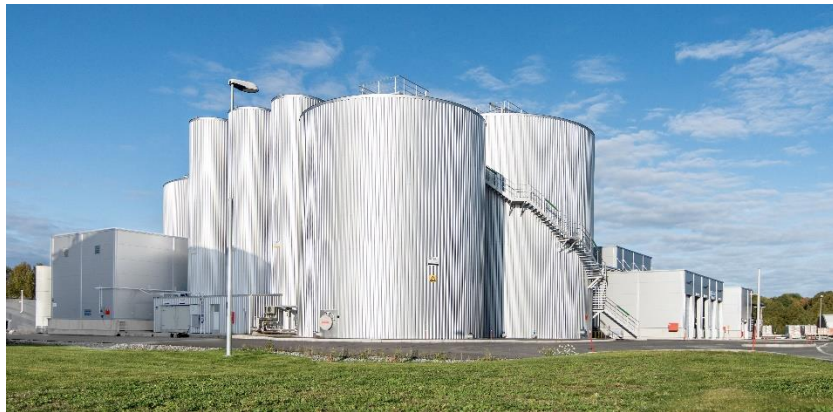
Figura 10. Esquema (elaboración propia) de reactor EGSB e imagen de instalación EGSB - Biothane en la planta de tratamiento de aguas residuales industriales de Borregaard (Noruega), cortesía de Biothane .
