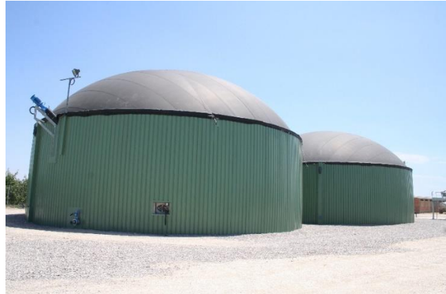
Figura 4. Esquemas (elaboración propia) de reactores CSTR y planta de codigestión anaerobia, con dos reactores CSTR en serie, en una granja de cerdos en Vilasana (Lleida), cortesía de ECOBIOGAS .
