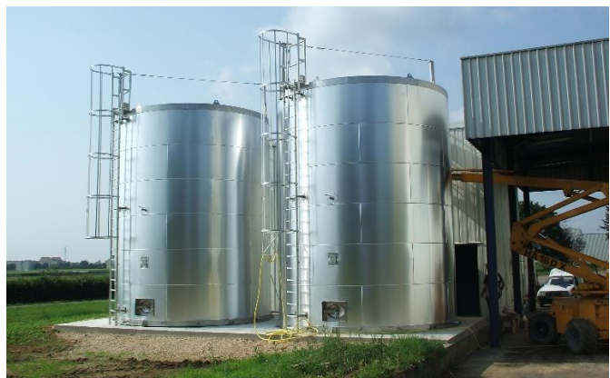
Figura 9. Esquema (elaboración propia) de reactor UASB e imagen de reactores UASB en la Quesería Gaugry (Brochon, Francia), cortesía de Valbio SAS.
