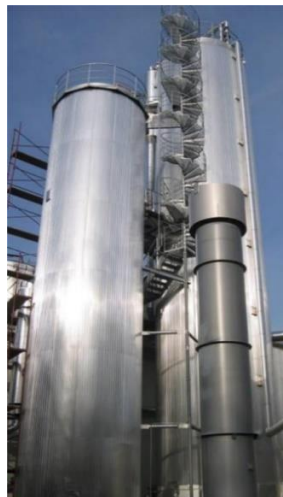
Figura 11. Esquema (elaboración propia) e imagen de reactor IC en una industria papelera en Holanda, cortesía de Jules van Lier (Universidad de Delft) y PAQUES .
