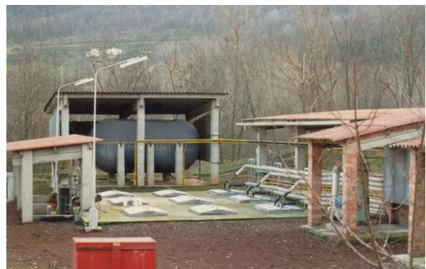
Figura 6. Esquema e imagen de planta de biogás de FP horizontal en granja de cerdos en Santa Pau (Gerona), diseñada por el autor y operativa de 1983 a 2003 (Flotats y Gibert, 2002).
