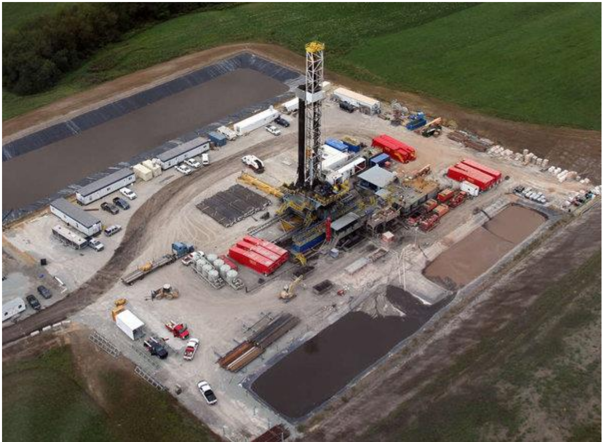
Figura 3. Lloc d'un pou en l'etapa de perforació
