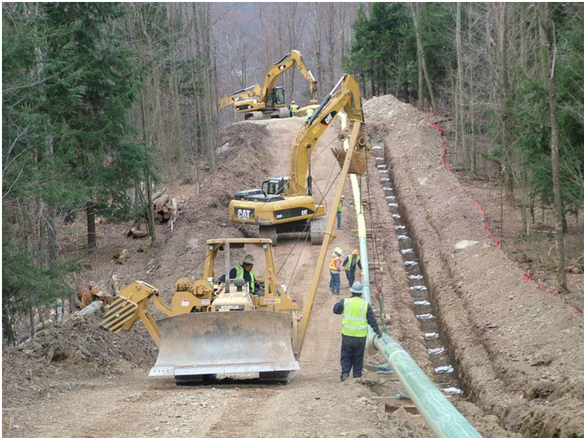
Figura 5. Construcció d'un gasoducte
