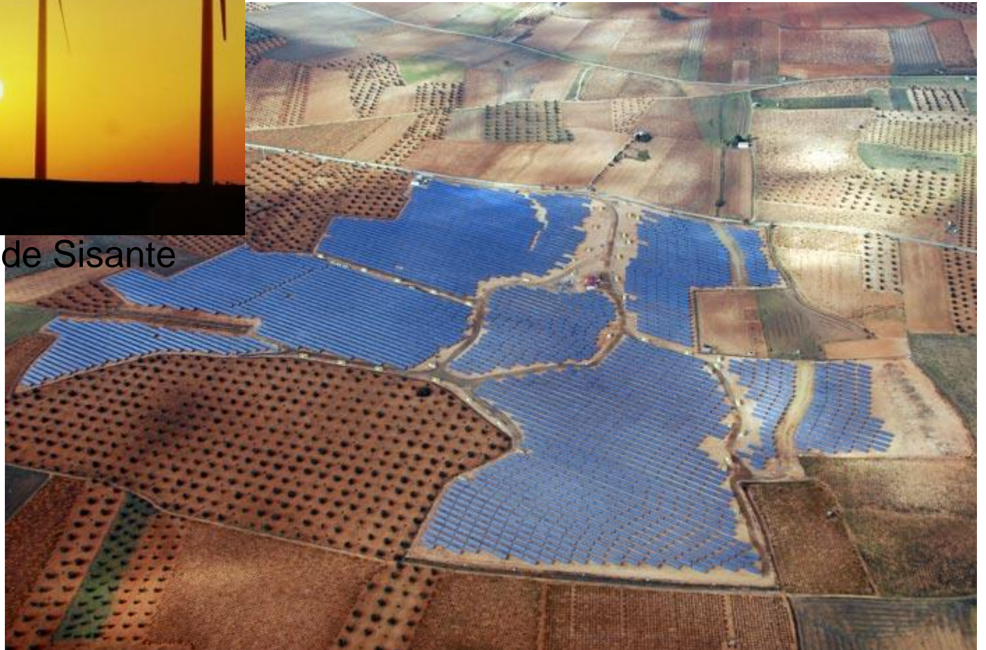
Huerto solar en Castilla La Mancha. Solaer
