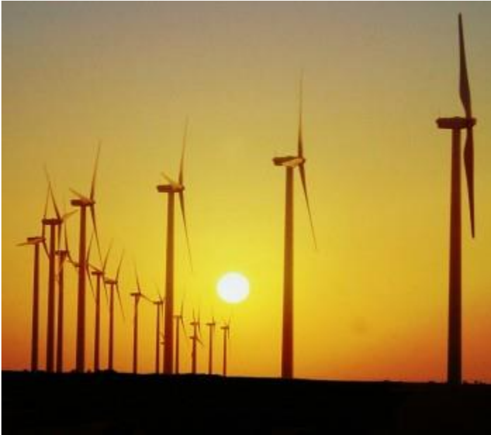
parque eólico de Sisante (Iberdrola)
