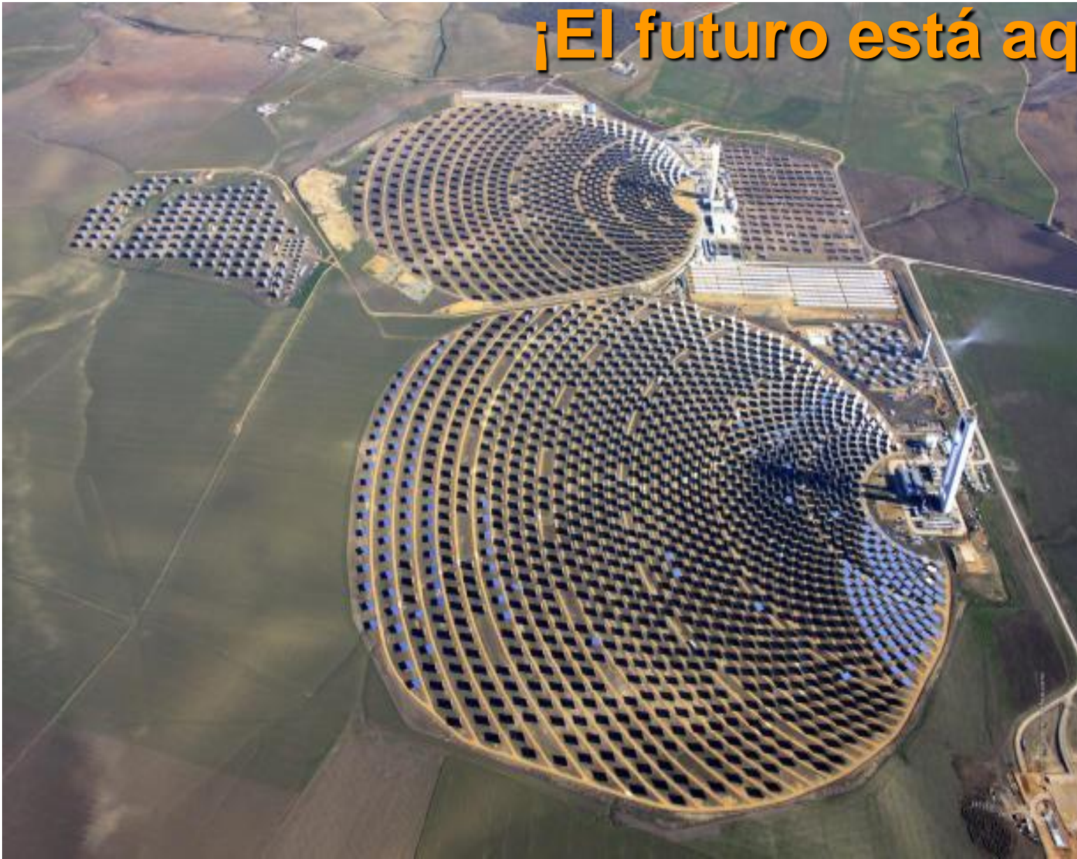
PS10 y PS20 centrales eléctricas Termosolares (Abengoa) en Sanlúcar (Sevilla)
